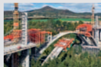
Coffrages de ponts
