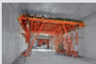
Coffrages de tunnels
