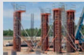
Coffrages de poteaux
