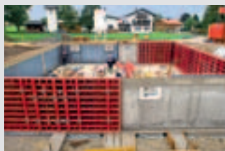
Coffrages de voiles
