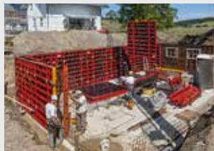
Coffrages de voiles
