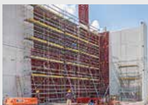
Echafaudages de ferrailage
