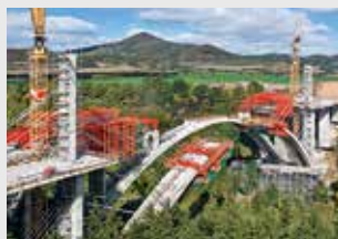
Coffrages de ponts
