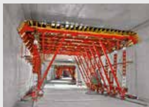
Coffrages de tunnels
