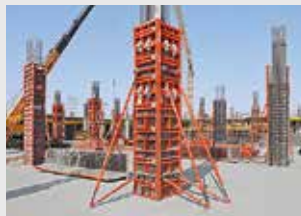
Coffrages de poteaux
