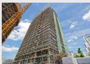
Echafaudages de façades
