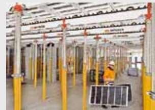
Coffrages de dalles
