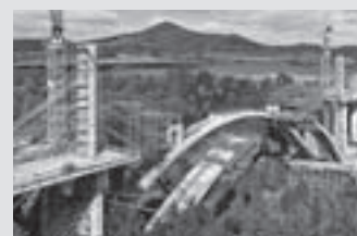
Coffrages de ponts
