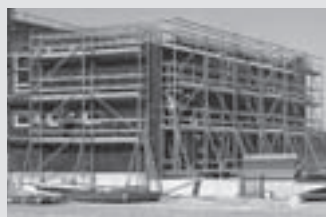
Echafaudages de ferrailage
