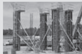
Coffrages de poteaux
