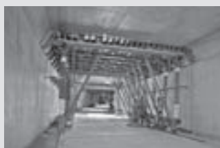
Coffrages de tunnels
