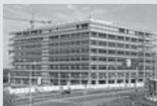
Echafaudages de façades
