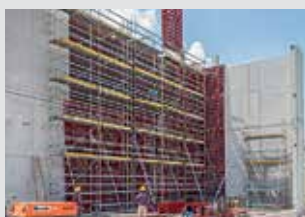
Echafaudages de ferrailage
