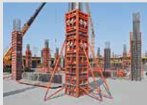
Coffrages de poteaux
