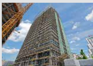
Echafaudages de façades
