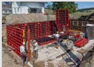
Coffrages de voiles
