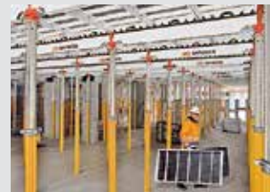
Coffrages de dalles
