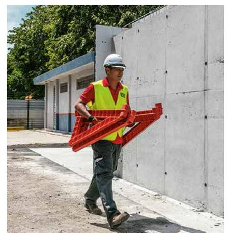
DUO présente des ouvertures ergonomiques dans les éléments de cadre pour la mise en place des connecteurs. Ces ouvertures servent parallèlement de poignées pour la manutention des éléments sur le chantier. Elles garantissent une manipulation aisée et améliorent l'ergonomie.
