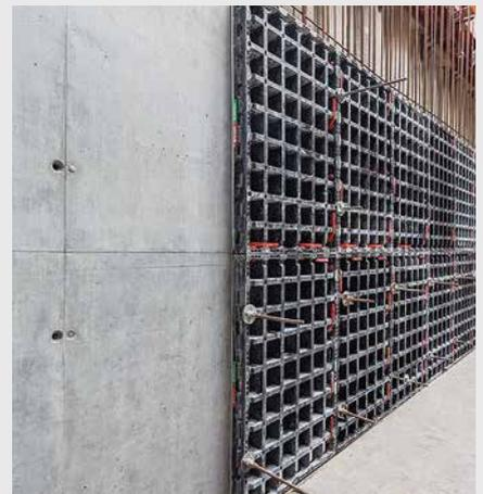
Le béton n'adhère presque pas, les panneaux se décoffrent donc facilement. On obtient ainsi des surfaces de bonne qualité.
