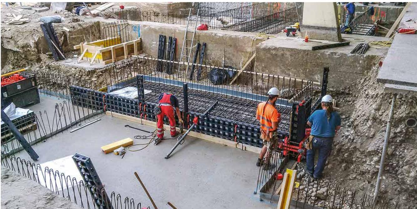
**Les éléments de construction DUO de petit format sont faciles à utiliser et rendent le coffrage des fondations particulièrement efficace. Vous pouvez utiliser tous les panneaux DUO et les associer à souhait.**
