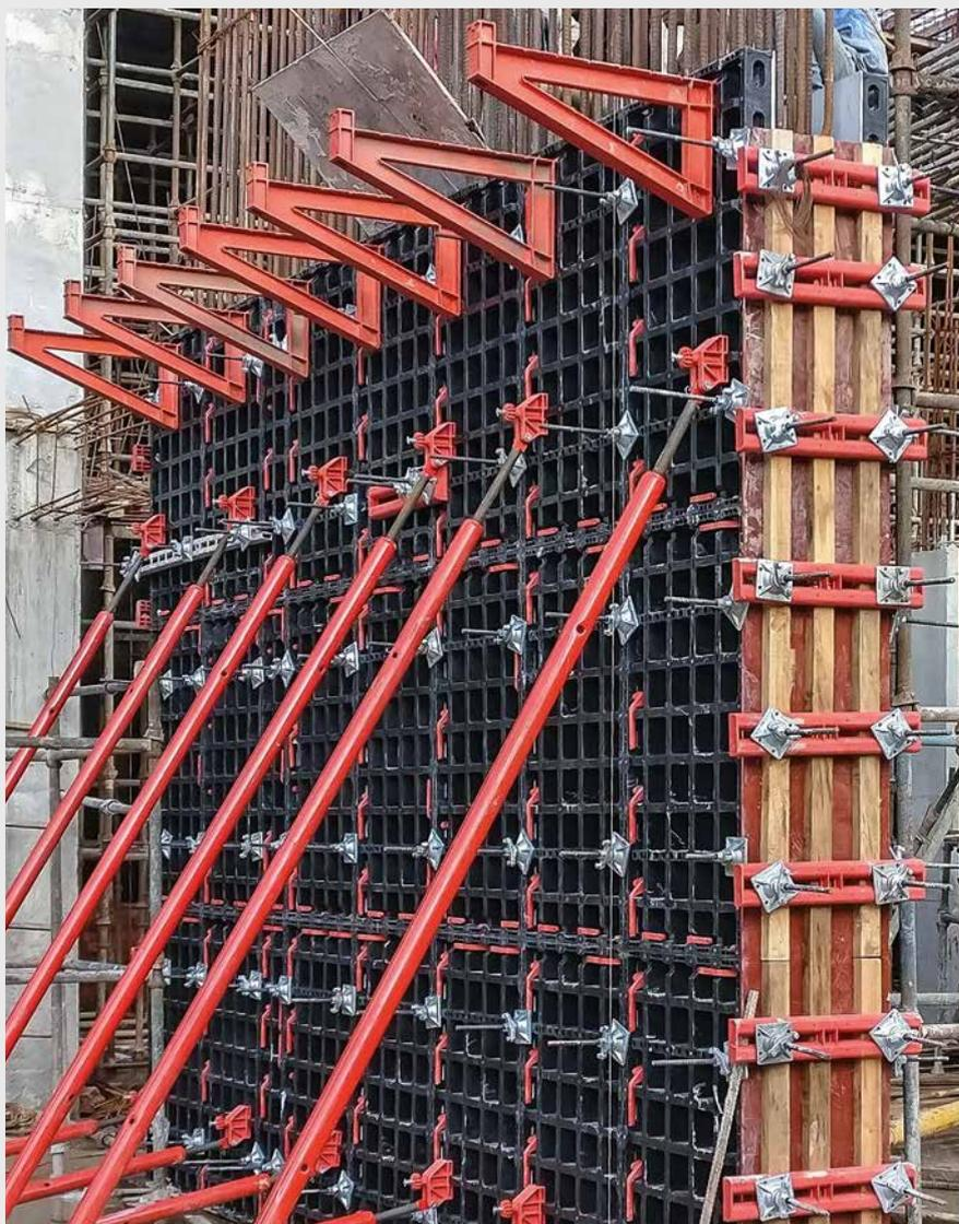
**Arrêt pour about jusqu'à une épaisseur de voile de 35 cm avec éléments standards**
