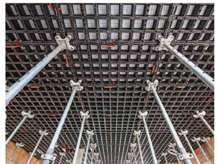
DUO a été optimisé pour des dalles d'une épaisseur allant jusqu'à 30 cm. La tête d'étais universelle DFH s'adapte à tous les étais courants en tube d'acier.
