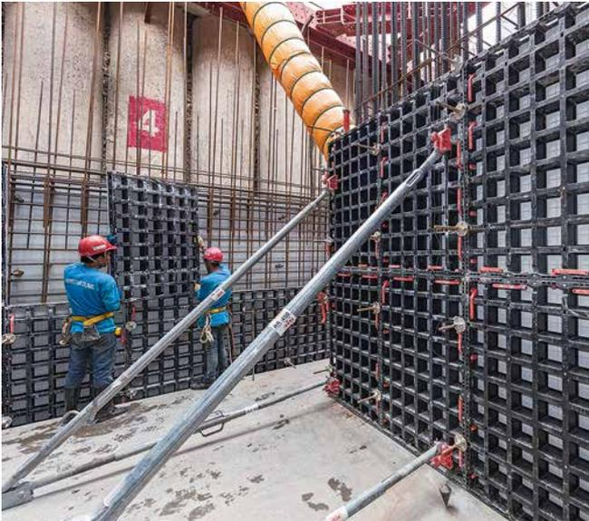
Légèreté, éléments de coffrage de petit format : le système DUO a pleinement fait profiter l'équipe de ces avantages dans la fabrication des voiles des étages souterrains.
