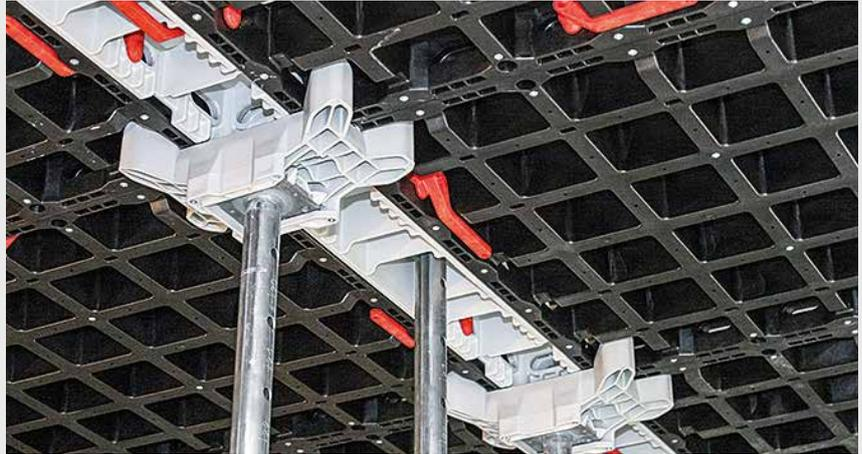
**Pour l'étaieage de séchage de la dalle, placez une bande de compensation entre deux panneaux. La tête d'étaieage de séchage DBH plus large s'engage dans les panneaux voisins.**
