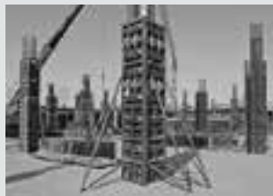
Coffrages de poteaux
