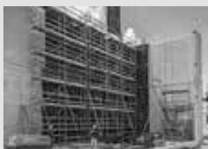
Echafaudages de ferrailage
