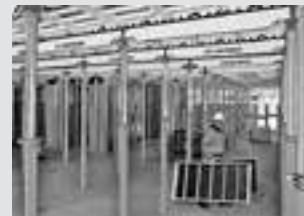
Coffrages de dalles
