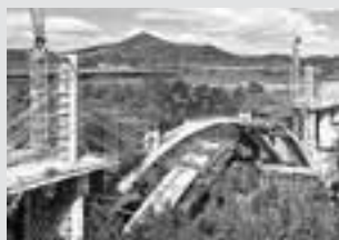
Coffrages de ponts
