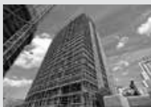
Echafaudages de façades
