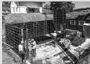
Coffrages de voiles
