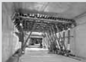
Coffrages de tunnels
