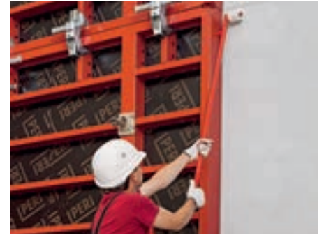
Décoffrage plus facile des éléments à l'aide du levier de décoffrage, sans risque d'endommagement. Le galet de guidage prévient en outre l'endommagement du voile en béton.
