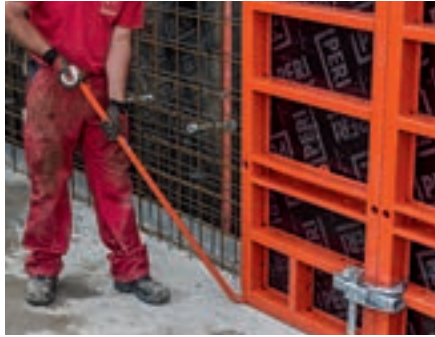
L'angle de ripage sert à la mise en place des éléments, sans l'utilisation d'un marteau.
