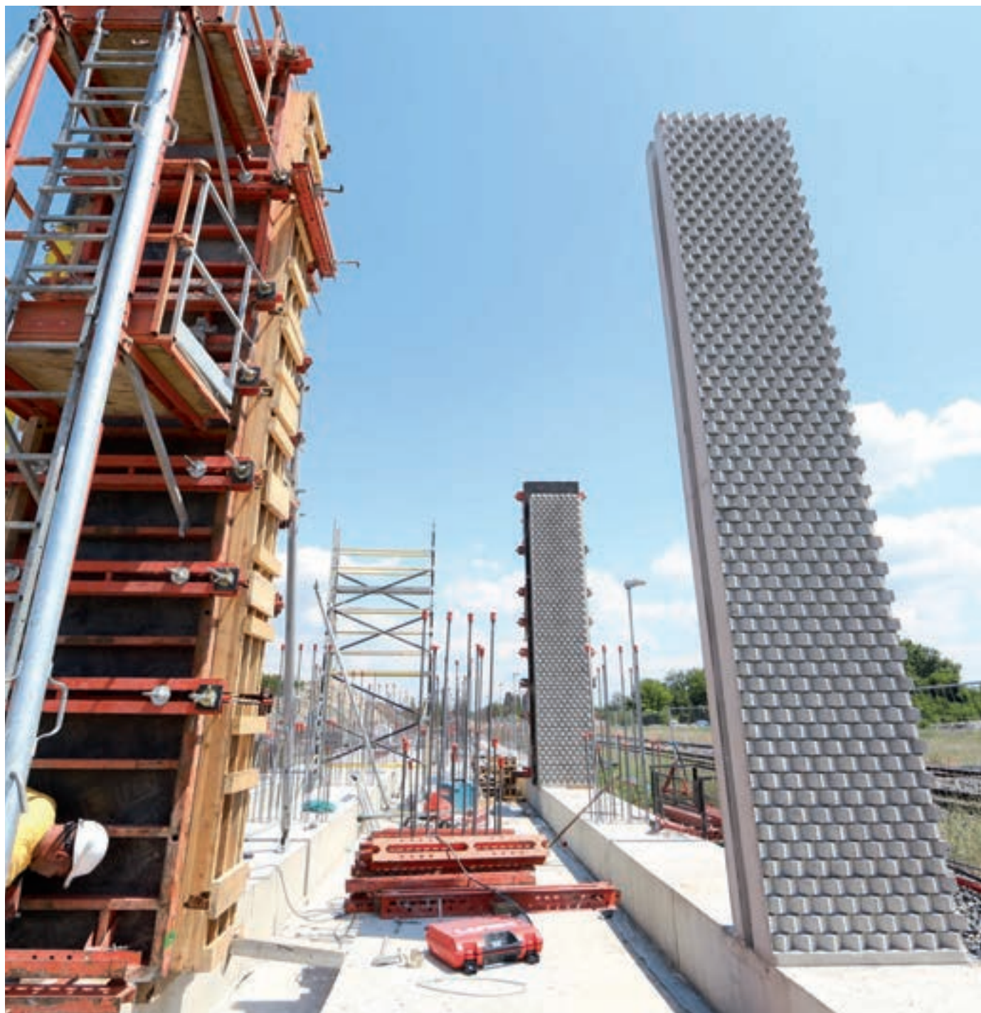
TRIO Structure utilisé pour des poteaux : doté d'une matrice, il engendre une structure de surface intéressante.
