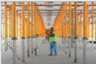
Coffrages de dalles
