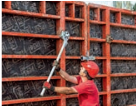
La clé d'ancrage sert à serrer et desserrer les écrous à oreilles, sans l'aide d'un marteau. Gain de temps énorme, particulièrement pour les ceintures d'ancrage supérieures.
