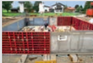
Coffrages de voiles
