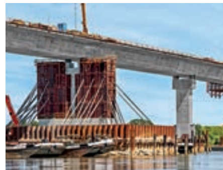
Pont sur la Vistule de Kwidzyn, Pologne
