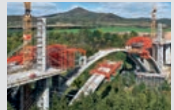
Coffrages de ponts
