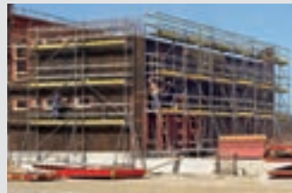
Echafaudages de ferrailage
