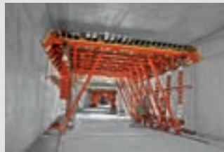
Coffrages de tunnels
