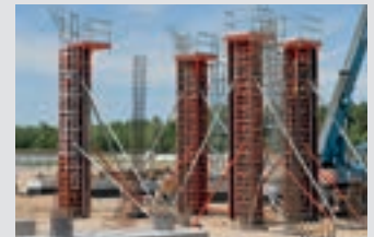
Coffrages de poteaux
