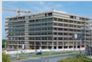
Echafaudages de façades
