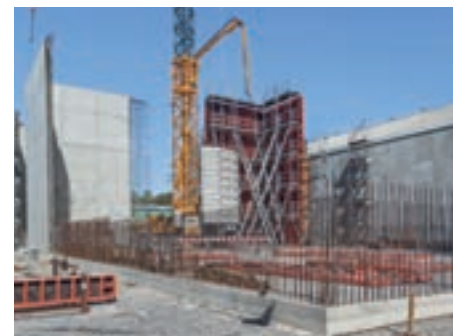
TRIO Structure peut être combiné avec les éléments standards TRIO. Cela présente un avantage car ces surfaces spéciales sont souvent exigées que sur une face.
