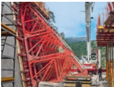
Le principe de raccordement solidaire employé permet de déplacer l'ensemble en une seule opération.
