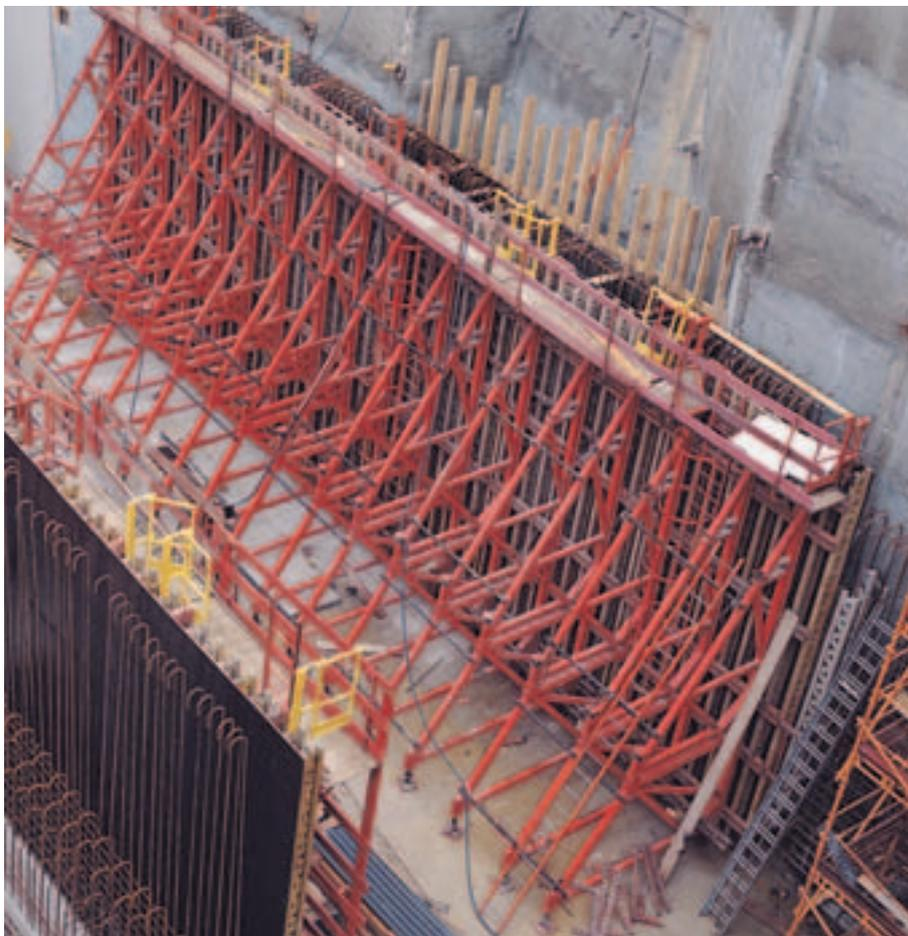
Les fermes de butonnage se montent sur les éléments placés à plat sur le sol. Le principe de raccordement employé permet de lever l'ensemble en une seule opération.
