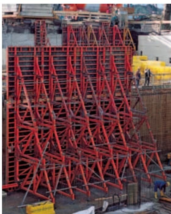
Ferme de butonnage SB-B, C avec TRIO, hauteur de coffrage 3,90 m.
