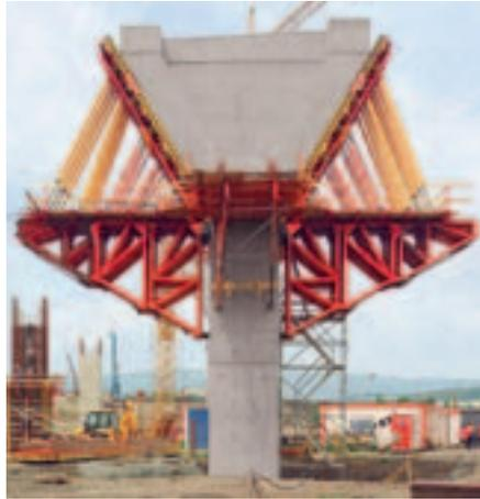
La distance et le nombre de sections de fermes de butonnage sont imposés par la charge existante.
