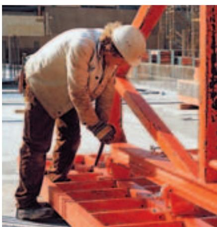
Hauteur de bétonnage jusqu'à 6,75 m avec SB-A, B, C et VARIO GT 24. Complet avec plate-forme de travail et échelle.
