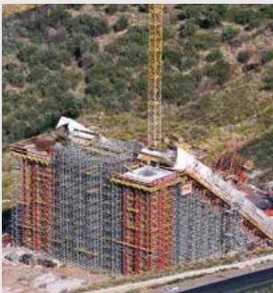
La conception du coffrage de superstructure et de l'étaieement destiné à cet avant-pont se base sur les systèmes flexibles en kit VARIOKIT et PERI UP. Les poutrelles de coffrage GT 24 forment la sous-construction destinée à la peau coffrante.
