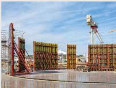
Les vérins de réglage auto-nettoyants du coffrage RUNDFLEX sont facilement réglés sur la courbure désirée à l'aide d'une clé à cliquet.
