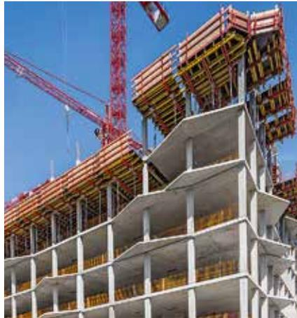
Les tables de coffrage avec poutrelles GT 24 et filières acier peuvent être conçues et montées selon des géométries spécifiques. Les ensembles peuvent être déplacés rapidement à l'aide d'un palonnier.
