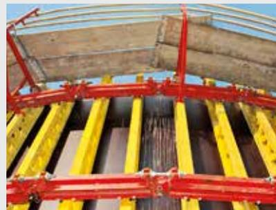
**Les coffrages de poteaux doivent être conçus pour une pression de bétonnage relativement élevée, le bétonnage étant effectué rapidement en présence d'une section relativement réduite. La poutrelle de coffrage GT 24, avec sa capacité portante élevée, est utilisée dans différents systèmes de coffrage de poteaux.**
