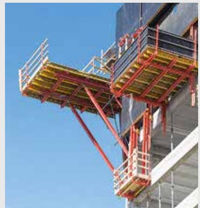
**Dans la construction de tunnels et de ponts, des modèles uniques sont réalisés de manière exclusive. Pour les solutions de coffrage spécifiques au projet, la poutrelle de coffrage GT 24 sert, dans de nombreuses configurations, de solide support pour la peau coffrante ou de support pour les plate-formes de travail.**
