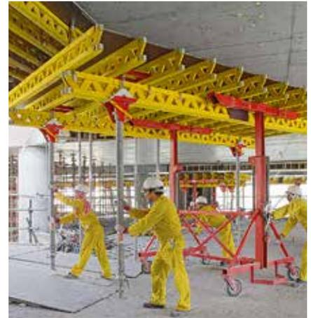
Particulièrement en présence de grandes épaisseurs de dalles et de charges élevées, des tables de coffrage peuvent être réalisées à l'aide des poutrelles de coffrage GT 24 à haute capacité portante.
