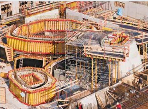
Le centre Galileo de contrôle par satellite, basé à Oberpfaffenhohen près de Munich est un ouvrage hors norme en béton architectural : le hall est dominé par trois tours inclinées en béton armé de plus de 9 m de haut. PERI a conçu et livré les négatifs de coffrage dans les délais imposés et avec une qualité optimale. Une précision de forme maximale et un résultat de surface particulièrement remarquable ont été obtenus sur place.
