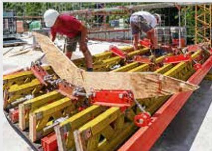
GRV est la solution de coffrage circulaire qui s'utilise sans ancrage et pour n'importe quel rayon. Les articulations de la filière GRV permettent de coffrer également de petits rayons de 0,60 m.
