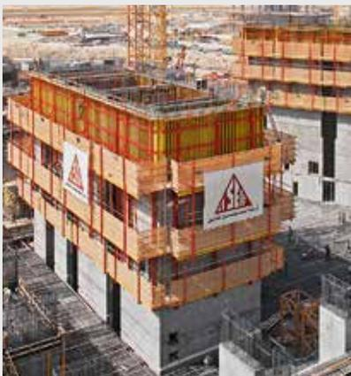
Les coffrages grim pants RCS et CB formaient, avec le système VARIO GT 24, la combinaison grim pante idéale pour une réalisation rapide de deux pylônes du pont.
