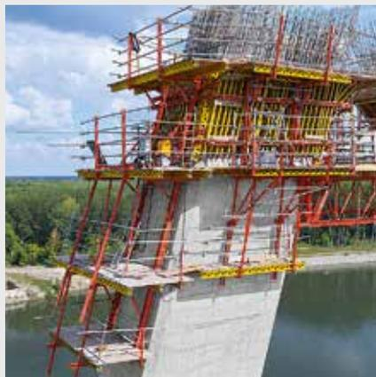
En raison des angles inclinés du bâtiment, des plate-formes d'angle spécifiques au projet ont été utilisées ici : des poutrelles de coffrage portantes GT 24 ont formé le support de platelage.
