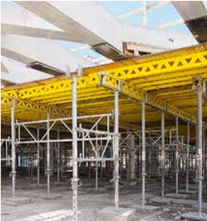
Le coffrage de dalle MULTIFLEX – réalisé avec des poutrelles de coffrage GT 24 – supporte ici un coffrage destiné à un «réseau» de poutres en béton architectonique, lequel supportera ultérieurement une dalle préfabriquée.
