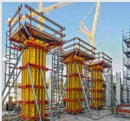
Le coffrage poteaux VARIO QUATTRO peut être déplacé par grue sous forme d'unité complète. Les filières portantes et repliables permettent des sections allant jusqu'à 1,20 m x 1,20 m.
