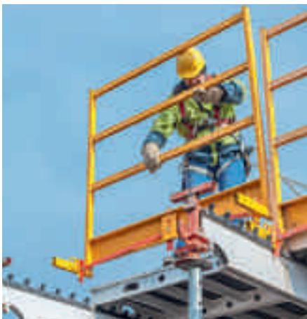
Le garde-corps complet se monte en un tour de main de manière rapide et sûre ; aucun élément complémentaire, ni outil n'est nécessaire.
