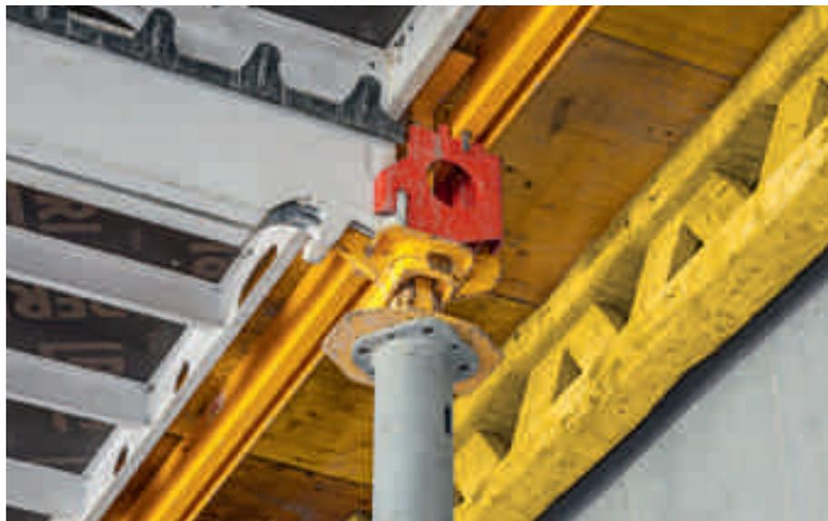
Les poutrelles de rive SRT 150 ou SRT 75 sont utilisées pour le coffrage autour de poteaux. La longueur maximale du bord du poteau est de 138 cm ou de 63 cm, en fonction de la poutrelle de rive utilisée.
