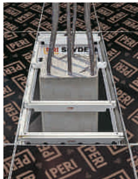
**Les variantes de têtes permettent de changer la direction des poutrelles primaires et donc des panneaux.**
