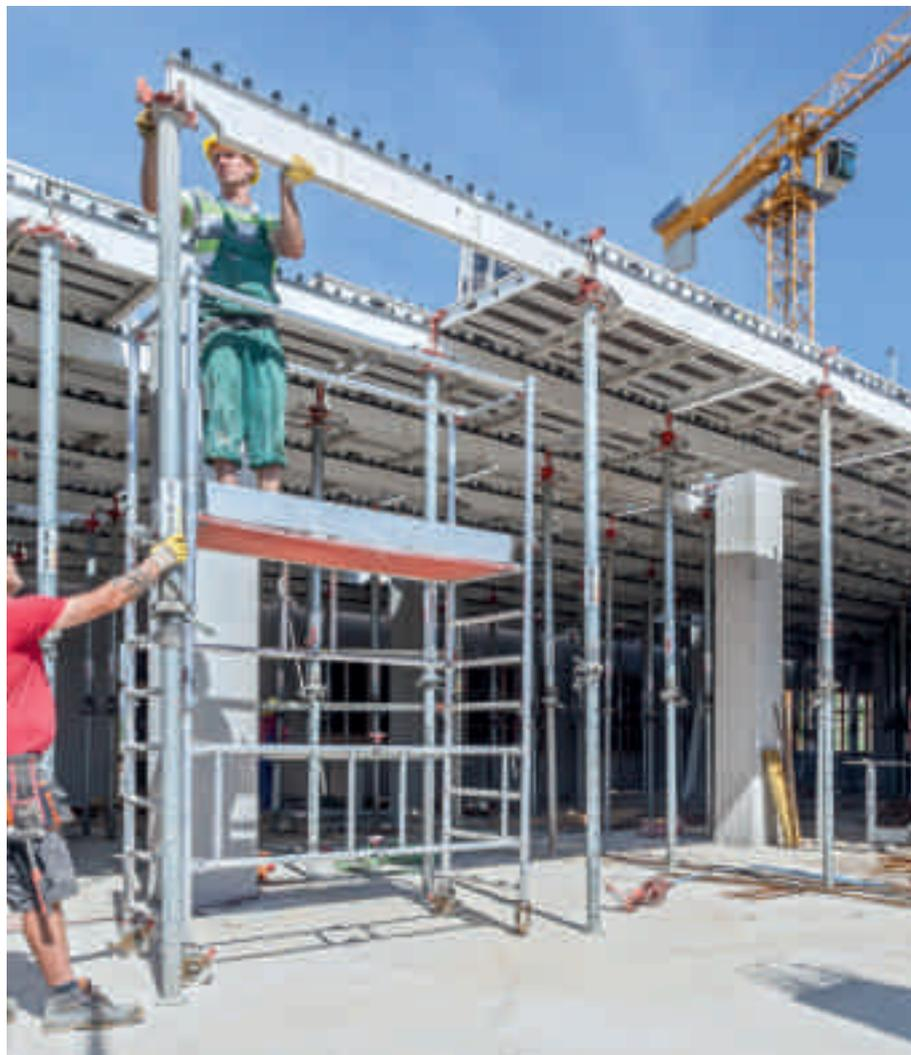
Les dents, orientés vers l'extérieur de la poutrelle primaire, sécurisent le panneau contre la chute ou le glissement. Il en résulte une haute sécurité lors du coffrage.
