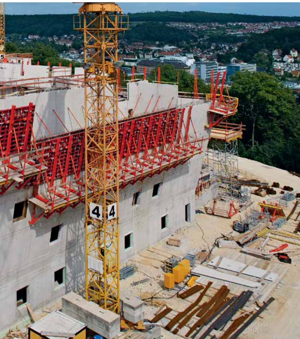
MAXIMO mis en œuvre sur passerelles repliables FB 180. Centre de logistique Siemens, Francfort
