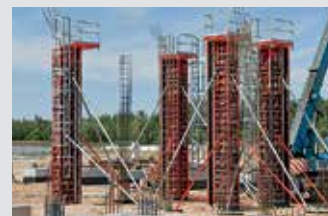
Coffrages de poteaux
