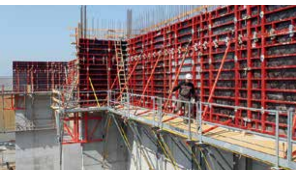
MAXIMO mis en œuvre sur passerelles repliables FB 180. Centre de logistique Siemens, Francfort
