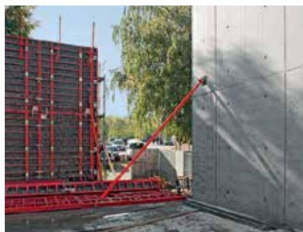
Trames de joints et d'ancrages régulières sur voiles apparents. Centre commercial Outlet-Center, Metzingen
