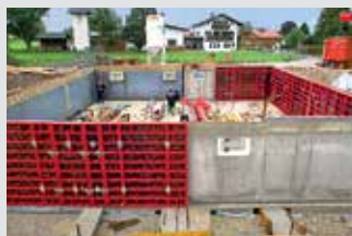
Coffrages de voiles
