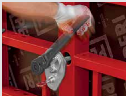
Visser l'ancrage MX à l'aide de la clé d'ancrage MX jusqu'à ce que la vis de fixation puisse venir s'appliquer.
