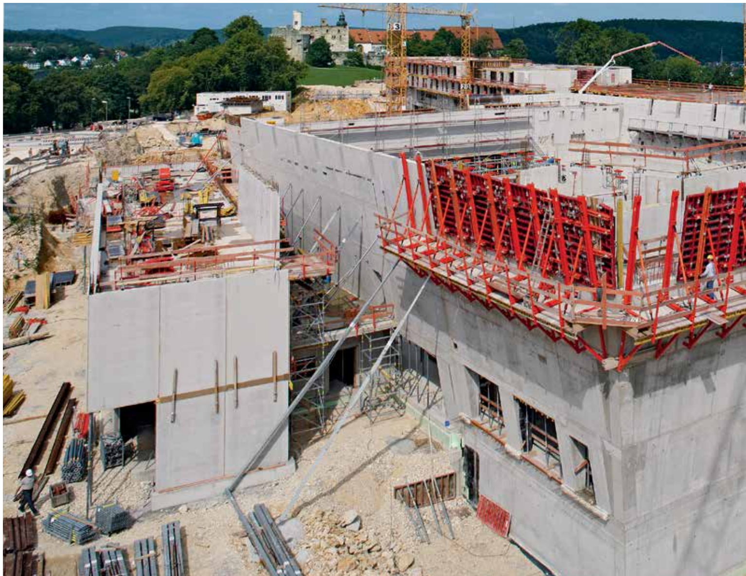
Courte durée des travaux et sécurité élevée. MAXIMO et PROKIT, barrière grillagée de protection latérale sur consoles de bétonnage. Sous-sol de maison, Weißenhorn
