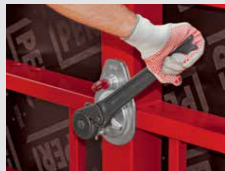
Visser complètement l'ancrage MX à l'aide de la clé d'ancrage MX.
