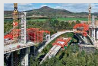
Coffrages de ponts
