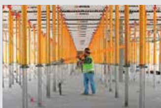
Coffrages de dalles
