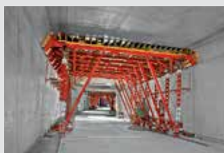
Coffrages de tunnels
