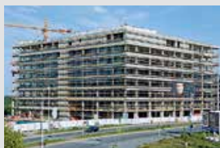
Echafaudages de façades
