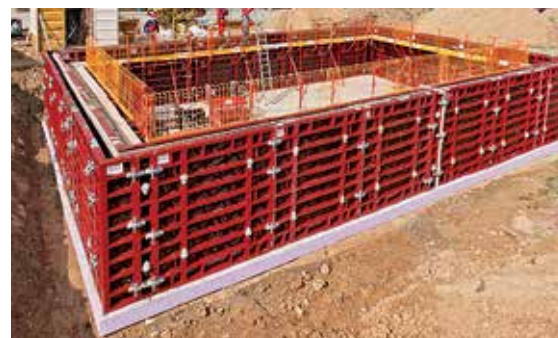
Courte durée des travaux et sécurité élevée. MAXIMO et PROKIT, barrière grillagée de protection latérale sur consoles de bétonnage. Sous-sol de maison, Weißenhorn
