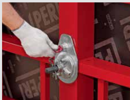
Bien serrer la vis de fixation.
