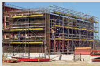
Echafaudages de ferrailage
