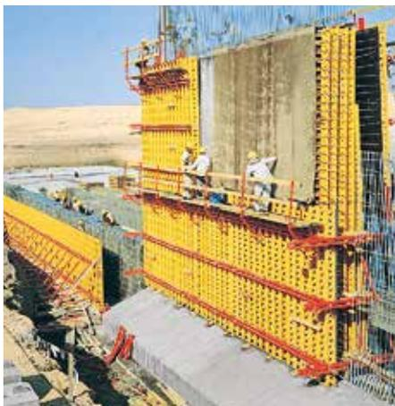
VARIO GT 24 lors de la construction d'une station d'épuration à parois coniques.
