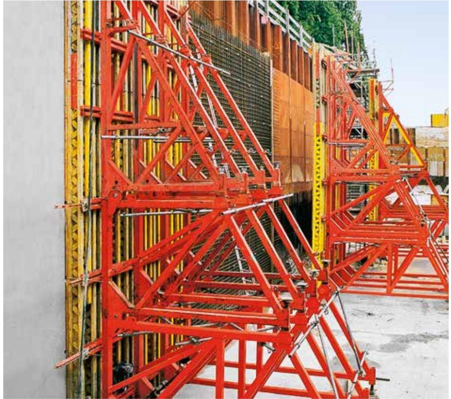
Hauteur de bétonnage max de 8,75 m, fermes de butonnage A0, A, B et C avec coffrage pour voiles VARIO GT 24.
