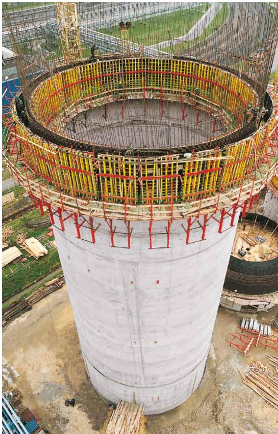
Silo, h = 72 m, Ø = 20 m de la centrale électrique d'Oppeln, Pologne. Réalisation avec coffrage poutrelles circulaire VARIO sur console grimpante KGF.
