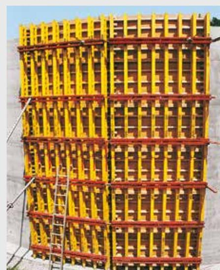
Coffrage circulaire de 7,50 m de haut avec planches segmentées sur les poutrelles GT 24.
