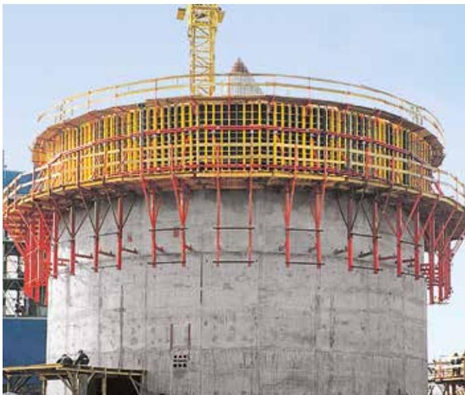
VARIO GT 24 lors de la construction d'un réservoir circulaire. Des coins en bois entre poutrelle et filière donnent la forme arrondie.
