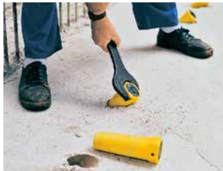
Le démontage du cône d'accouplement est effectué à l'aide de la clé à fourche SW 70.
