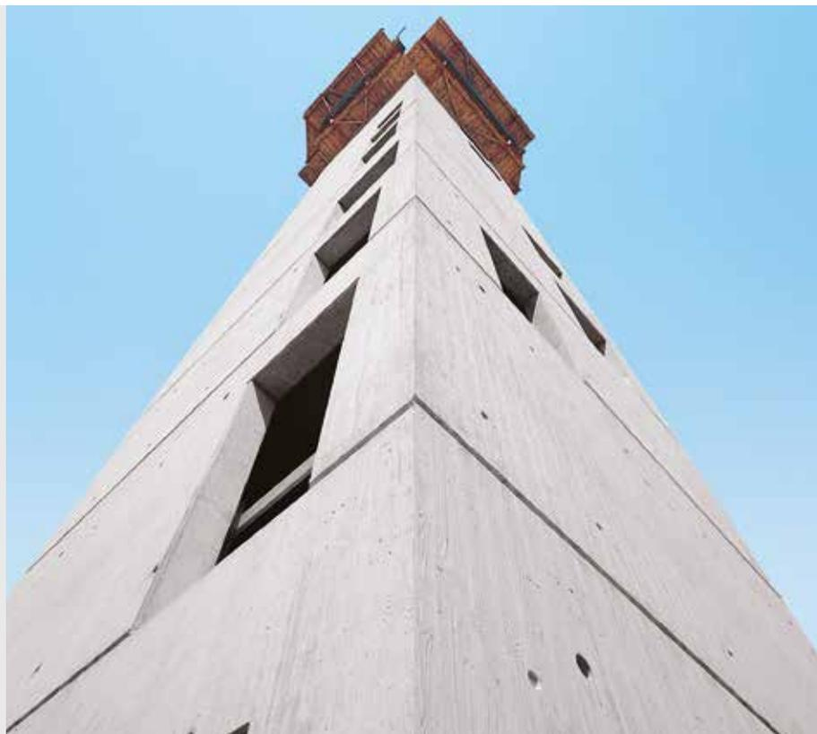
Surface de béton visuellement attrayante avec structure verticale rugueuse portant l'empreinte du veinage bois.
