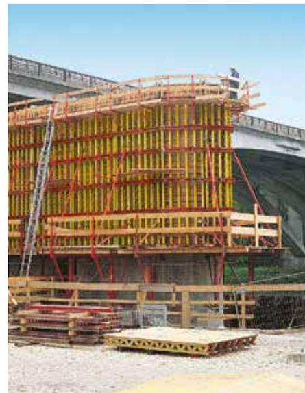
Sections de piles creuses au bord du fleuve, hissage avec VARIO GT 24 sur console grimpanche PERI KG 240. L'adaptation aux faces frontales courbes a été réalisée à l'aide de pièces standard VARIO et de doublages.
