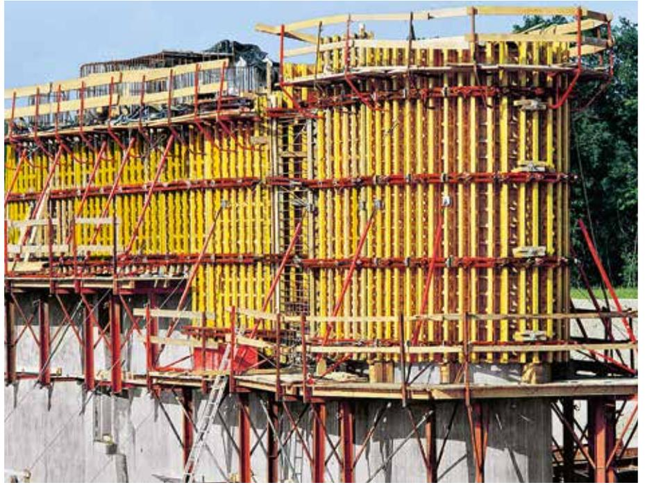
Face avant des piliers du barrage. VARIO en liaison avec le système de coffrage circulaire GRV sur console grimpante KGF 240.
