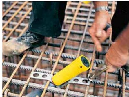
Fixation simple de l'ancrage sur le ferrailage : Avec du fil de fer et des pinces.
