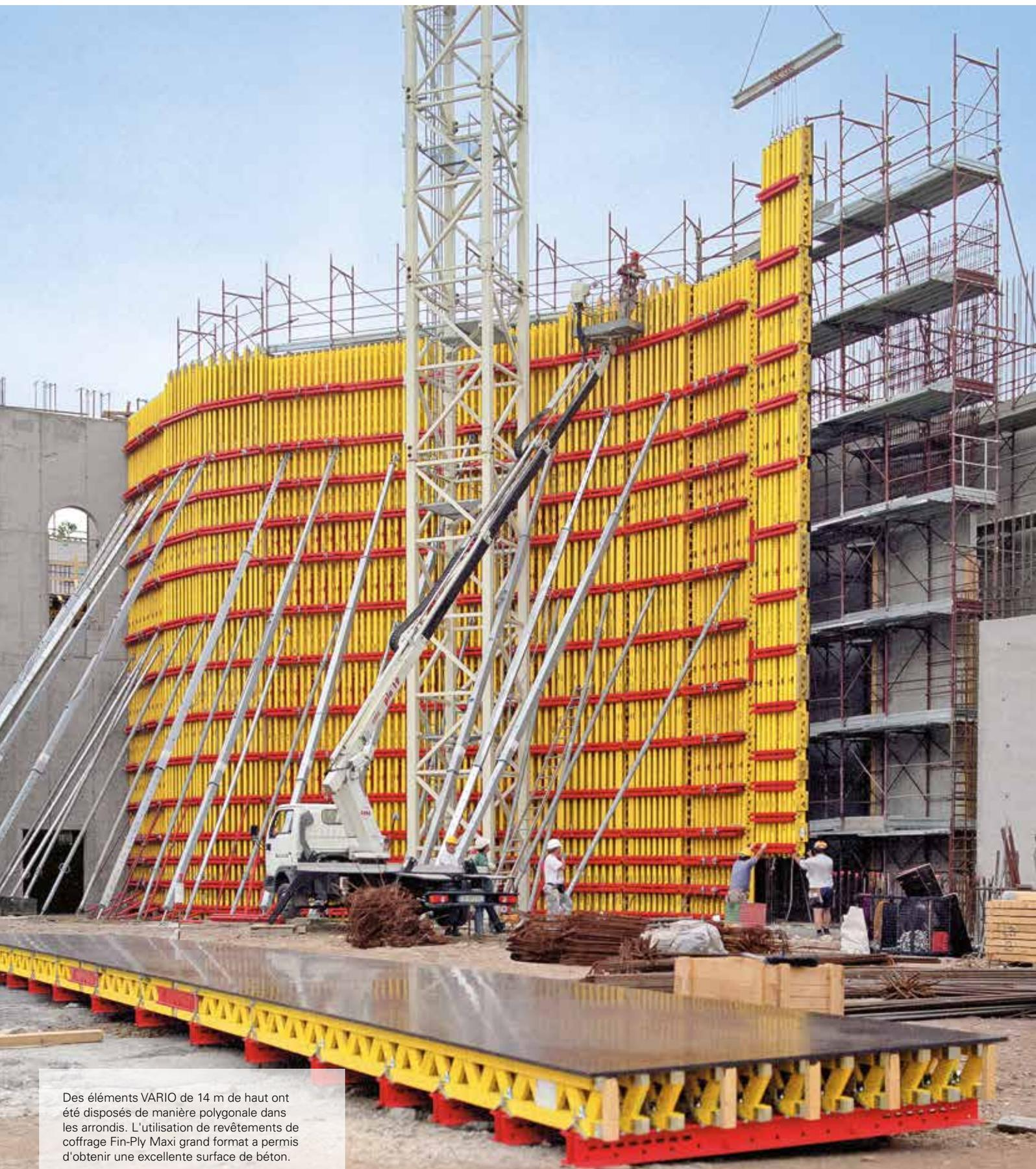
Des éléments VARIO de 14 m de haut ont été disposés de manière polygonale dans les arrondis. L'utilisation de revêtements de coffrage Fin-Ply Maxi grand format a permis d'obtenir une excellente surface de béton.
