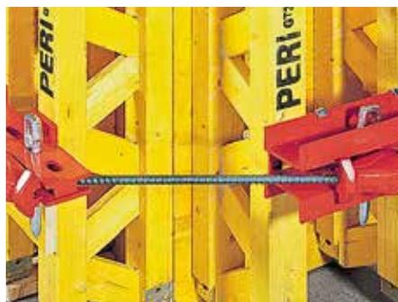
Au niveau de l'élargissement de l'élément, la poutrelle doit dépasser de 2 cm afin d'assurer une bonne précontrainte de l'angle.
