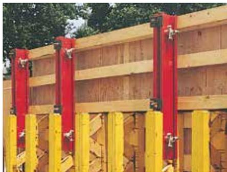
Le montage de l'aboutage 24 est effectué sans perçage des poutrelles, à travers le treillis de la GT 24.
