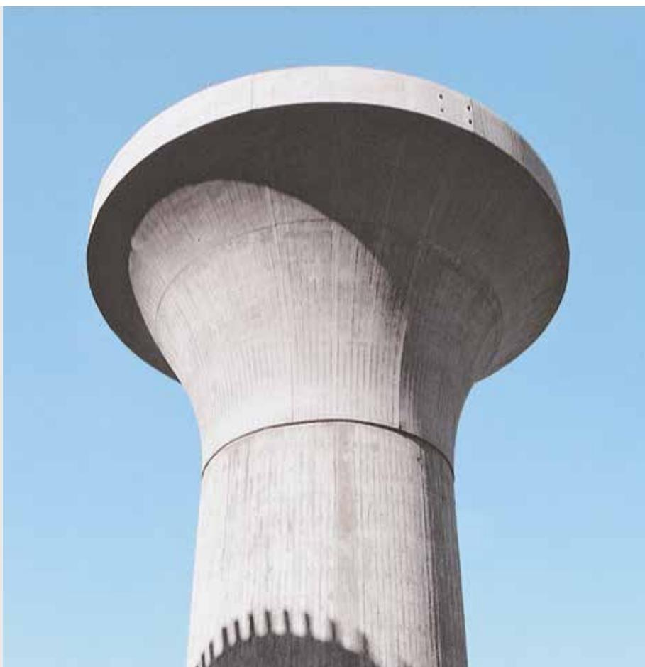
Sur le viaduc enjambant le Triebischbach, BAB 4, ont été réalisées des piles circulaires de 49 m de haut avec chevêtres en forme de trompettes.
