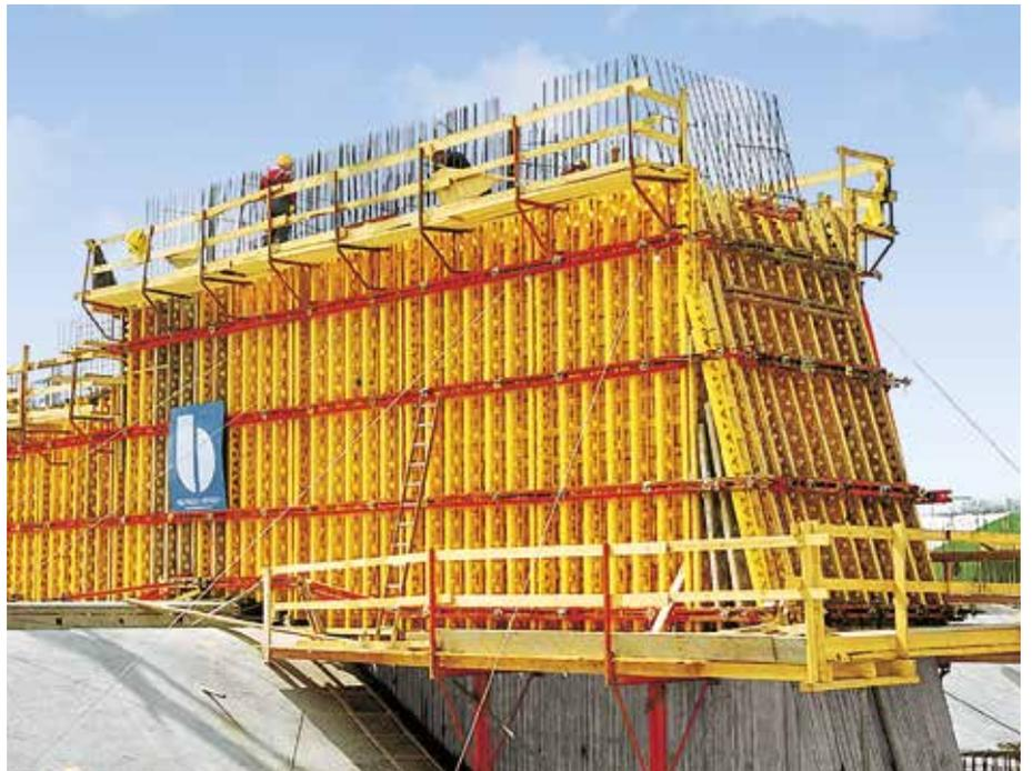
Centrale électrique de soutien pour l' Isar près de Plattling-Pielweichs. Coffrage de piles avec VARIO GT 24 en liaison avec le coffrage circulaire GRV. La surface du béton a été conçue sous forme de béton architectural avec structure verticale portant l'empreinte du veinage bois. La souplesse et la facilité d'adaptation rendent particulièrement rentable, dans ce domaine, le coffrage avec PERI VARIO GT 24.
