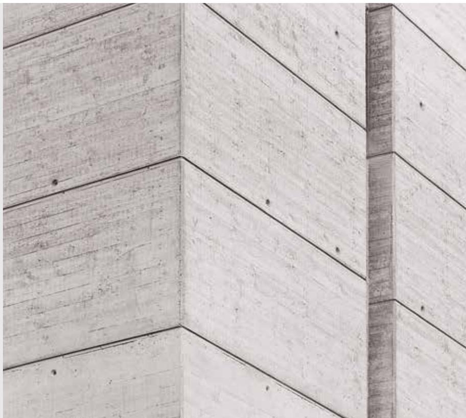
Béton architectural remarquable avec structure horizontale rugueuse portant l'empreinte du veinage bois.
