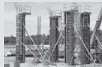
Coffrages de poteaux
