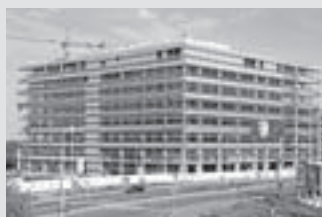
Echafaudages de façades
