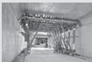
Coffrages de tunnels
