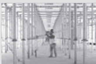
Coffrages de dalles
