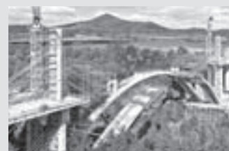
Coffrages de ponts
