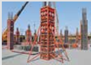
Coffrages de poteaux
