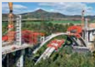
Coffrages de ponts
