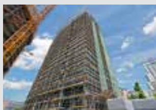
Echafaudages de façades
