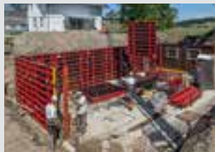
Coffrages de voiles
