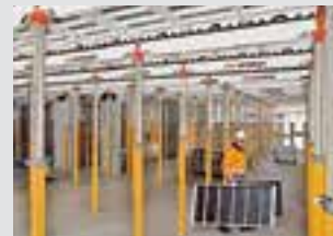
Coffrages de dalles
