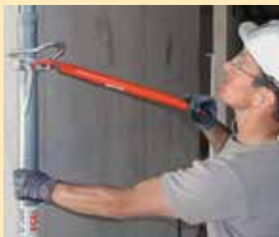
Travail ergonomique grâce à une clé de décintrement coudée.
