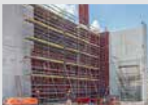
Echafaudages de ferrailage
