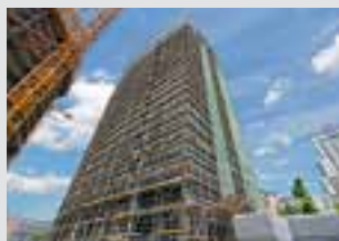
Echafaudages de façades
