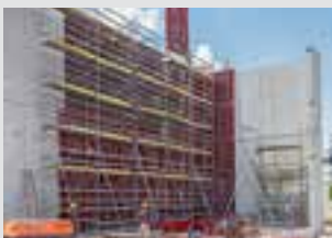
Echafaudages de ferrailage
