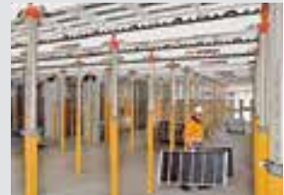
Coffrages de dalles
