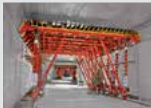
Coffrages de tunnels
