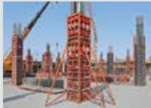
Coffrages de poteaux
