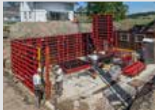
Coffrages de voiles
