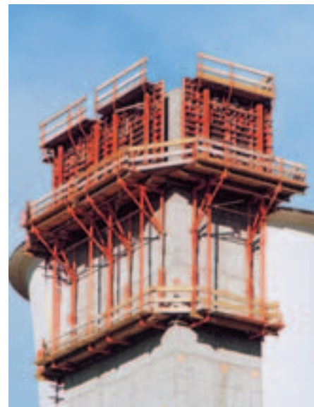
Bâtiment administratif CB 240 avec passerelles suspendues et coffrage TRIO.
