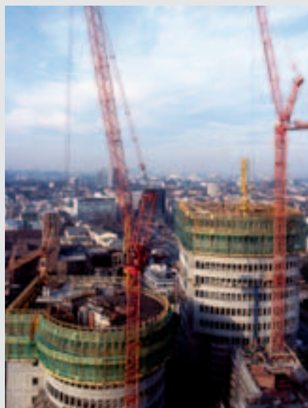
Bâtiment administratif CB 240 avec TRIO et VARIO GT 24.
