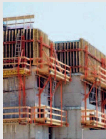
Sécurité Echelle d'accès PERI pour un accès sûr à la passerelle suspendue.
