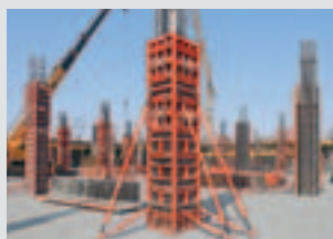
Coffrages de poteaux
