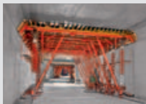
Coffrages de tunnels
