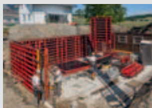
Coffrages de voiles
