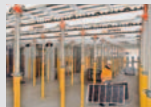
Coffrages de dalles
