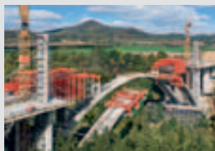
Coffrages de ponts
