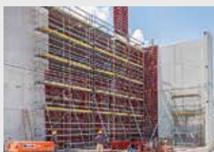
Echafaudages de ferrailage
