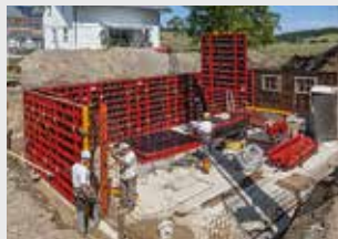
Coffrages de voiles
