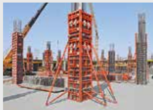
Coffrages de poteaux
