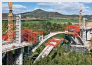
Coffrages de ponts
