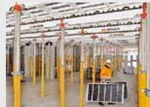
Coffrages de dalles
