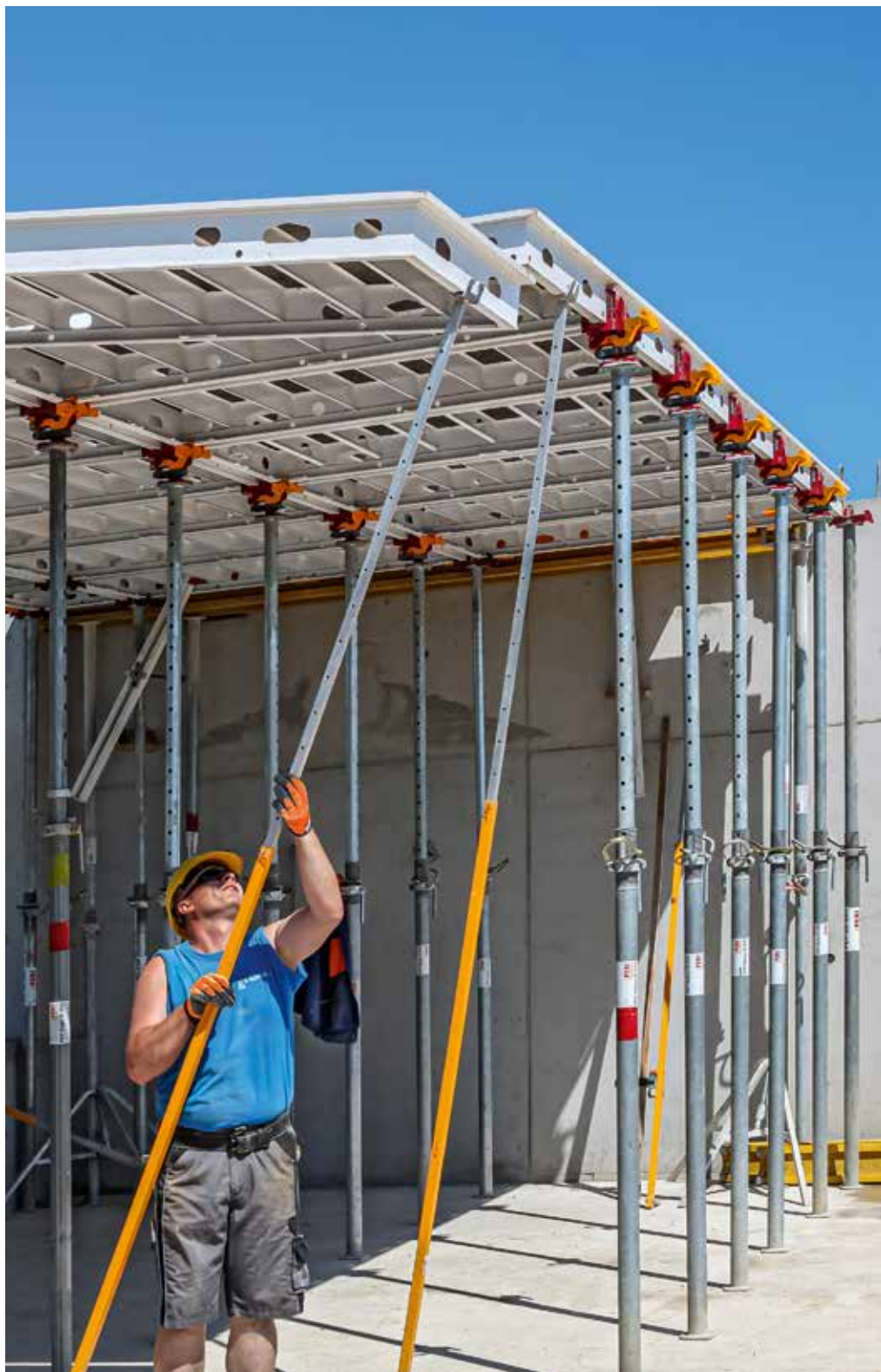
Ainsi, avec l'aide de coffrage, vous pouvez coffrer en toute rapidité et en toute sécurité des hauteurs de dalle allant au moins jusqu'à 3,80 m.
